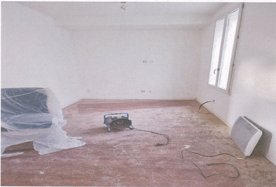
Travaux d'une pièce située sur l'aile droite,
